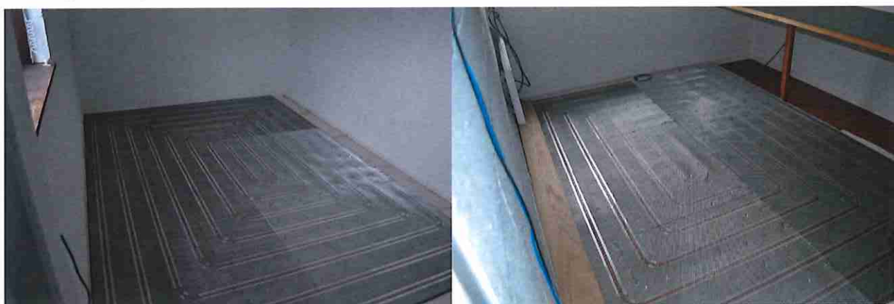
Figuur 1: Plaatsing van de vloerverwarming Opal System
