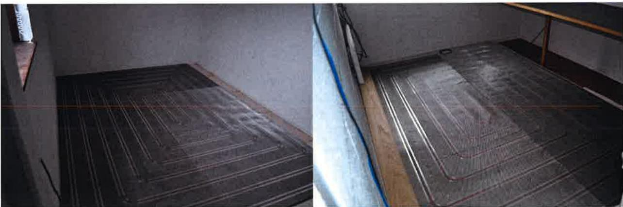
Figure 1 : Mise en place du chauffage par le sol Opal-System
