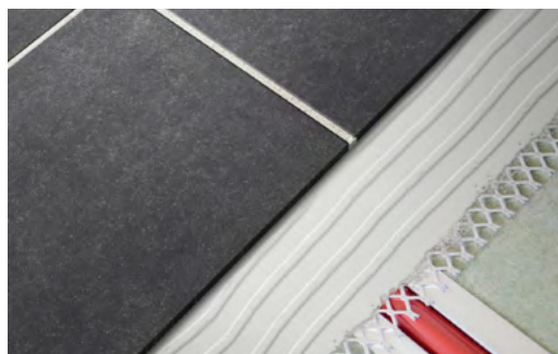
Voorbeeld waarbij tegels rechtstreeks op de verwarmer worden geplaatst met vervormbare mortellijm.
