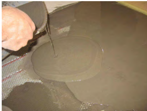
Égaline fibrée pouvant par exemple constituer la base pour la pose d'un linoléum ou d'un tapis
