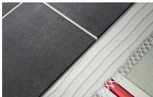
Exemple de pose directe de carrelage sur l'émetteur avec du mortier-colle flexible.
