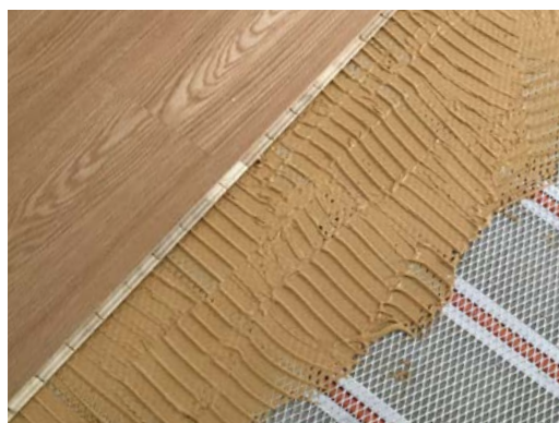
Il est également possible de coller directement un parquet avec de la colle PU par exemple.
