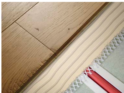
Il est également possible de coller directement un parquet avec de la colle PU par exemple.
