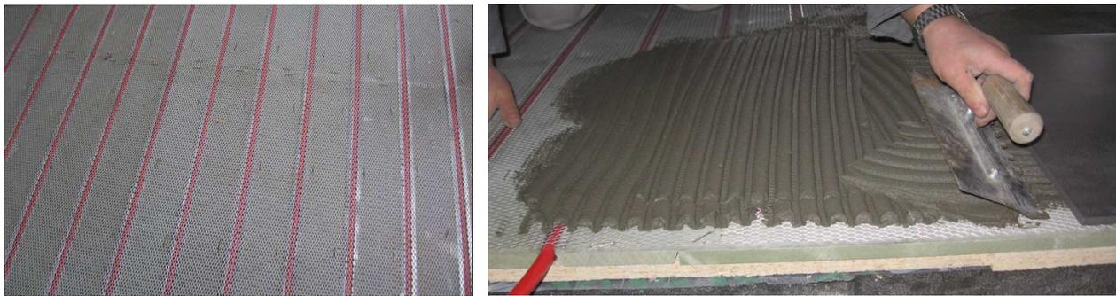
Exemple de pose directe de carrelage sur l'émetteur avec du mortier-colle flexible.
