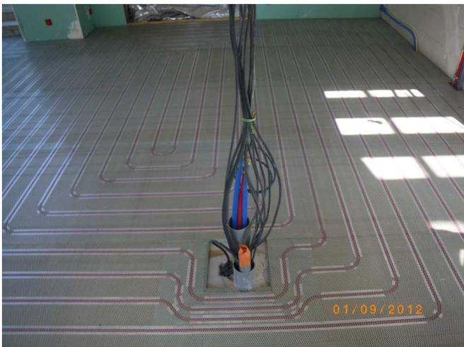
Il faut et il suffit que ces réservations aient été clairement marquées au le sol avant la pose du chauffage sol.
