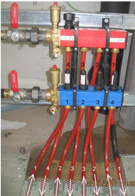
Comme illustré par la photo ci-contre, lorsque plusieurs tuyaux en parallèle alimentent une même zone thermique, leurs extrémités sont raccordées au collecteur en alternant les départs et les retours et en imbriquant les tuyaux.
