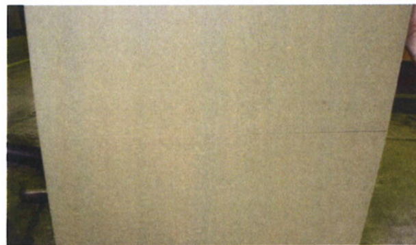
Figure 11 –Etat du dos du panneau MDF (support du système de chauffage) après essai.
