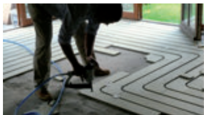
Pose sur chape Op een dekvloer (chape)
