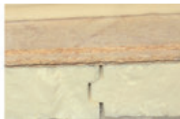
Pose sur panneaux OSB et PU Op OSB en PU platen
