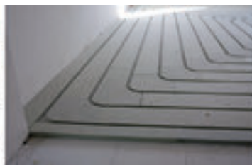
Pose sur chape sèche Fermacell Op een droge dekvloer
